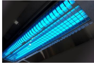
ภาพที่ 2-17 แสดงหลอดยูวีชนิดจุ่มน้ำไม่ได้
